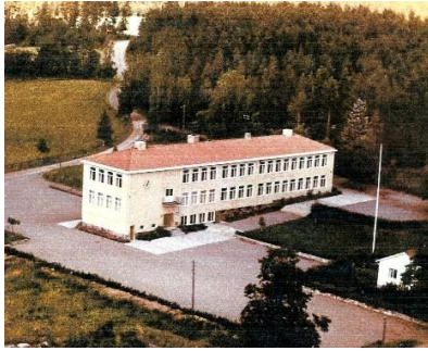
Nya skolan och vaktmästarbostaden längst ner till höger byggd 1952
