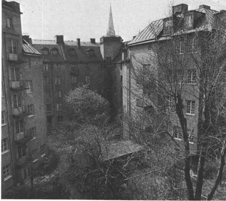
Kv. Norrtälje, gårdar mot nordväst.
