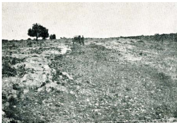
Fig. 18. — La voie romaine en déblai avec les deux murs rocheux la bordant.
