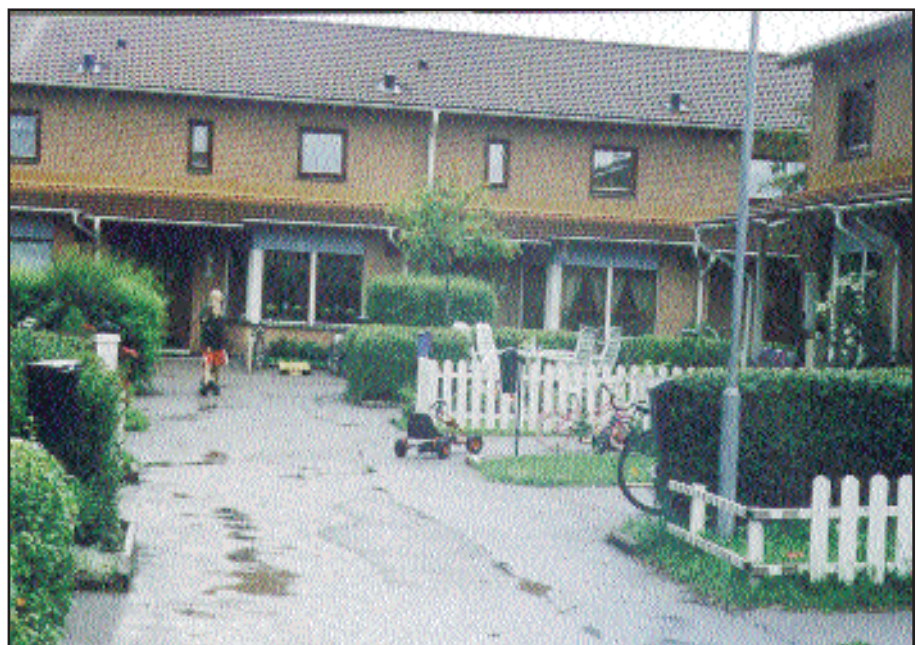
Bild 11. Gårdsbebyggelse som är inåtvänd, entréfasaden mot bakgården som har en privat gemenskap Foto: Jadranka Boras.
