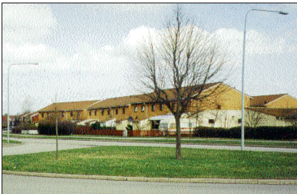
Bild 16. Ett stort antal likartade typhus (Ånggårdens) med små fönsteröppningar och gömda entréer, ensidiga fasadmateriäl och färg ger ett slutet och kalt intryck. Foto: Jadranka Boras.
