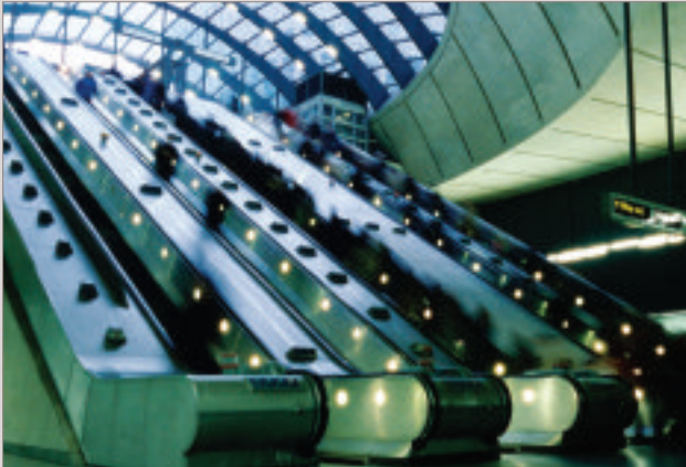
La toute nouvelle station de métro de Canary Wharf sur la Jubilee Line.
