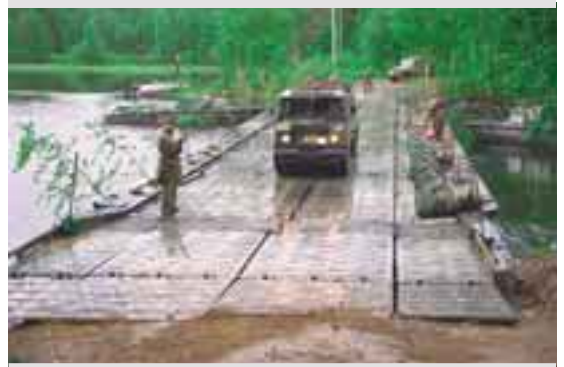
Pioneerien rakentama ylikulku ponttoonikalustolla.
