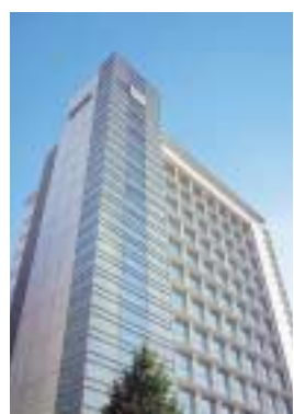
東京・渋谷の本社ビル
