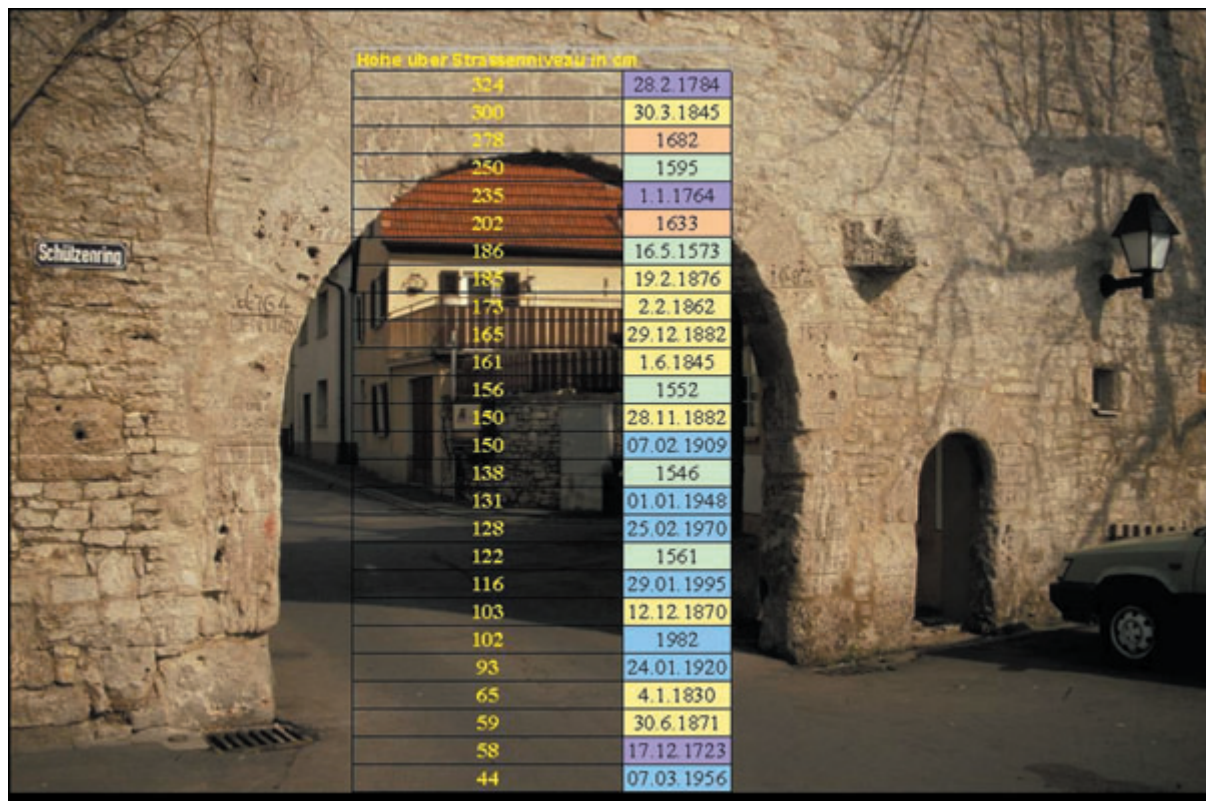
Abb. 2 Hochwassermarken in Eibelstadt am Main.
