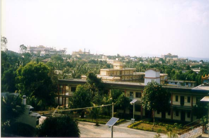
Fig. D3. A view of Sera, Bylakuppe
