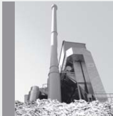
Das Biomasse-Heizkraftwerk Großbaitingen erspart durch die CO 2 -neutrale Verbrennung der Umwelt im Vergleich zu herkömmlich gewonnener Energie im Jahr rund 31.000 Tonnen Kohlendioxid.
