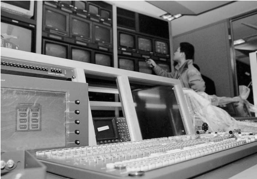
설치 끝낸 부조정실 : 개국을 앞두고 설 치를 마친 부조정실 방송장비(1994. 11. 28)
