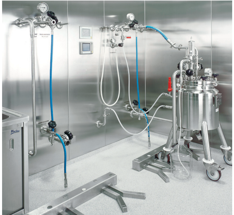
1: Andockstation für CIP/SIP im Reinraum
