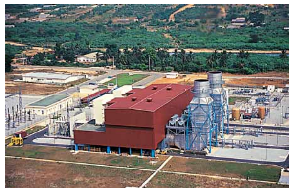
FINANCÉE PAR L'AKFED, LA SOCIÉTÉ SUÉDO-SUISSE ABB ET ÉLECTRICITÉ DE FRANCE, LA CENTRALE ÉLECTRIQUE D'AZITO A UNE CAPACITÉ DE 288 MÉGAWATTS, SOIT 30 % DES BESOINS EN ÉLECTRICITÉ DE LA CÔTE D'IVOIRE
