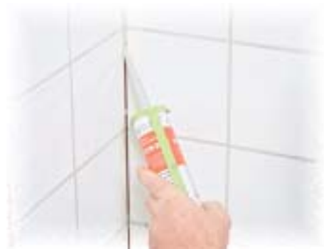
Nurkkien saumaus elastisella UZIN-D 80 -saumamassalla. ■
