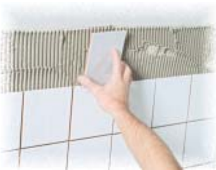
Laattojen kiinnitys UZIN-FLIESURIT PLUS -kiinnitysaastilla.
