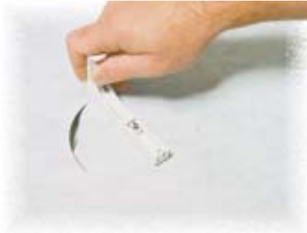
Lattiakaivoläpiviennin asennusta: kun UZIN-HS 600 -massa on kuivunut, leikataan läpivienni auki ja taivutetaan kiristysrenkaan alle.
