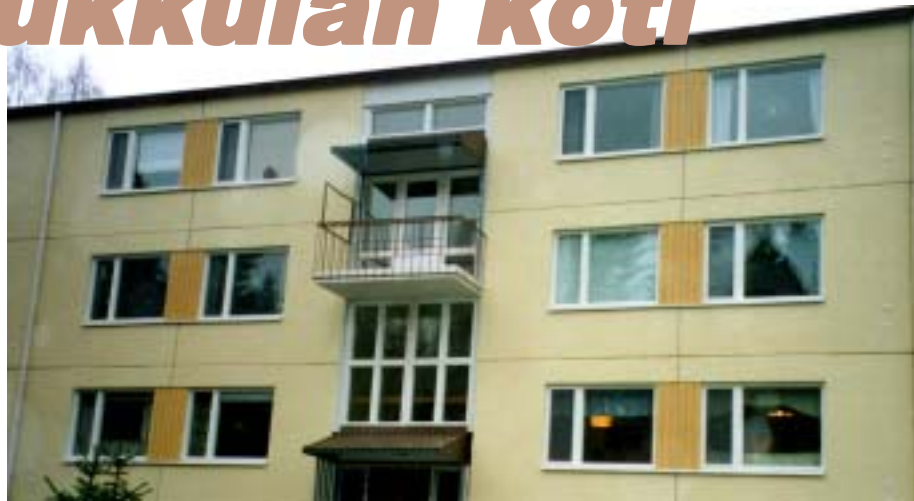
As Oy Kotimukkula Lahdessa kesän 2000 työvaiheiden jälkeen.
