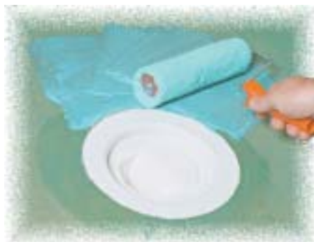
Lattiakaivoläpiviennin asennusta: pohjustetun lattian päälle levitetään ensimmäinen kerros UZIN-HS 600:aa.
