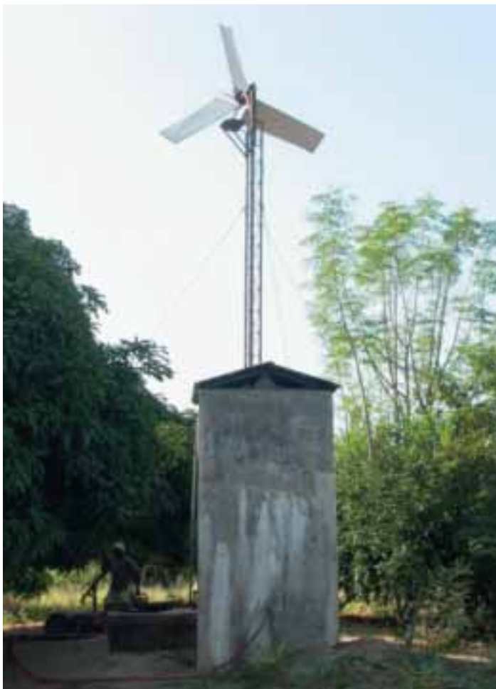
Bengt Häggblomin suunnittelema, yksinkertainen ja helposti valmistettava tuulipumppu täyttää kahdeksan kuutiometrin vesisäiliön kahdessa päivässä.
