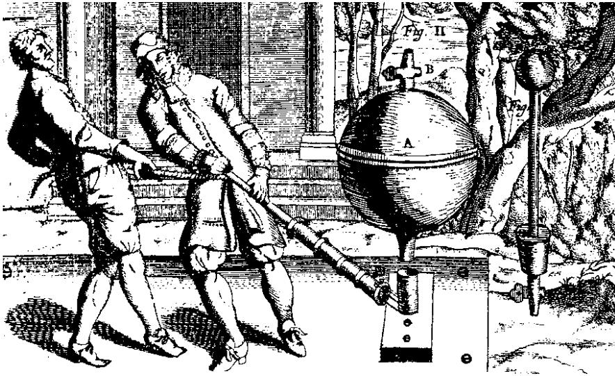
Abb. 10 zeigt zwei Männer bei der Entleerung einer Metallkugel von Luft
