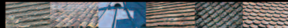
Dalles de pierre Tuiles creuses, tuiles «tige de botte» Zinc Tuiles plates Tuiles «violon» Tuiles écaille
