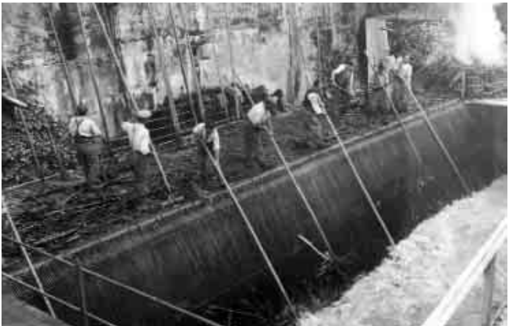
Einlauf zum Kraftwerk Kallnach. Rechenreinigung als gefährliche Handarbeit, 5. Juni 1935.
