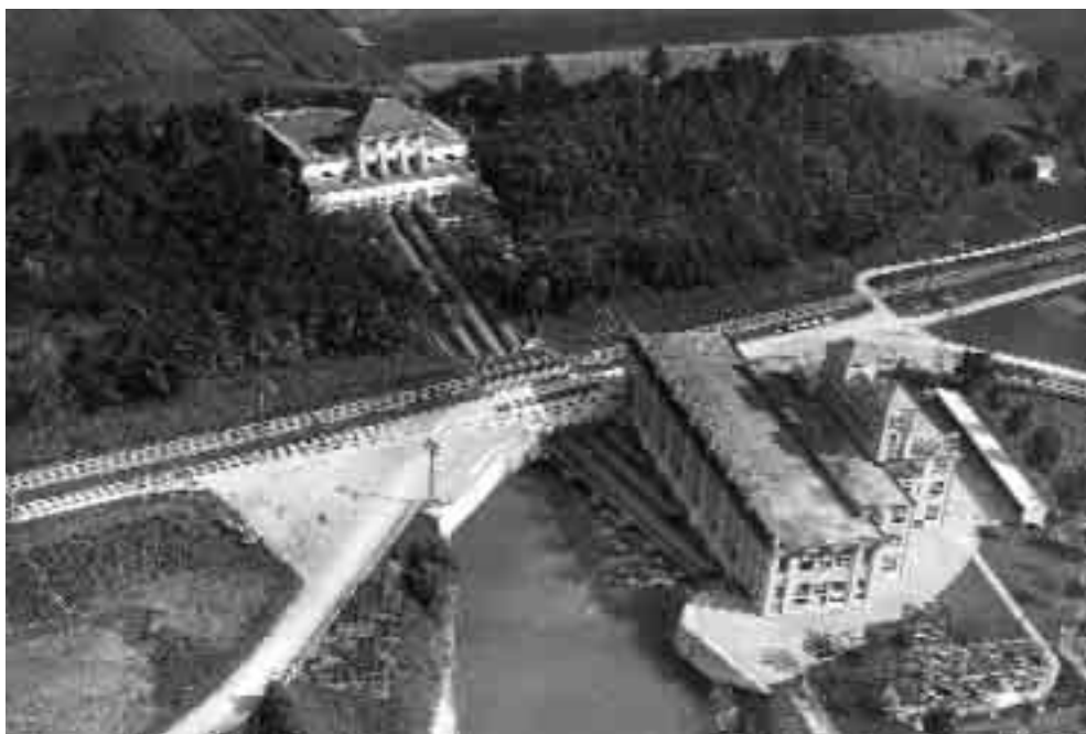
Wasserkraftwerk Kallnach, erbaut 1909 bis 1913 mit Wasserschloss (links), Druckleitungen (Mitte) und Maschinenhaus (rechts).
