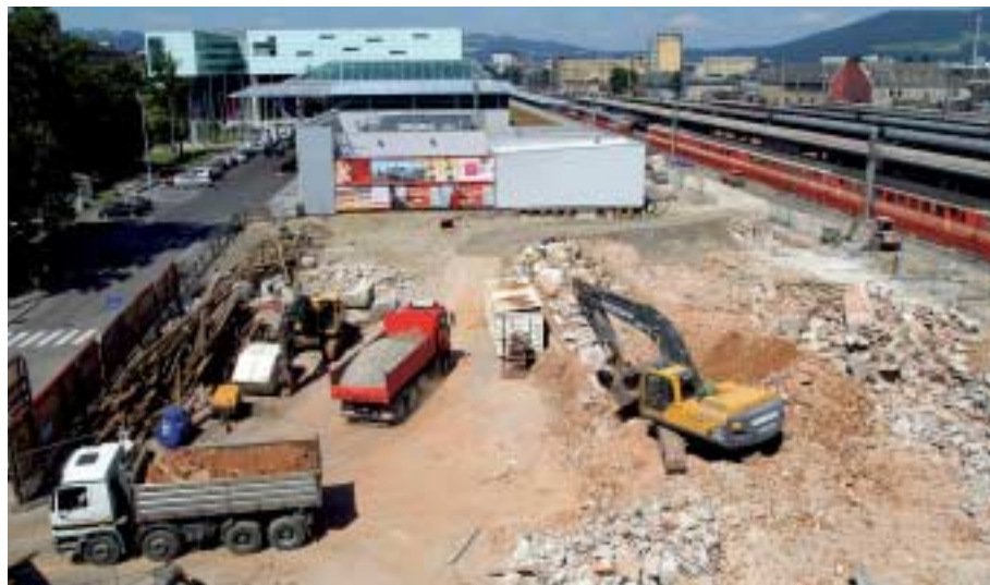
Der Abbruch des alten ÖBB-Aufnahmegebäudes machte den Weg für die Einbindung der LILO frei.
