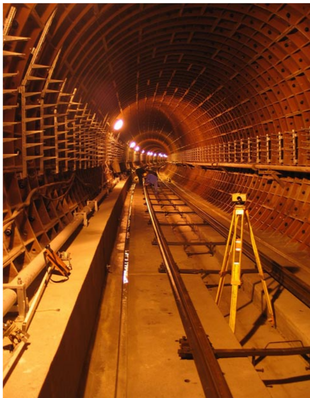
Budowa stacji Plac Wilsona. Dziennie z warszawskiego metra korzysta ponad 430 tys. osób.
