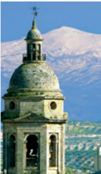
Torre de la Iglesia Santa Catalina en Loja
