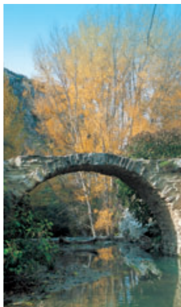
Puente romano de Alhama
