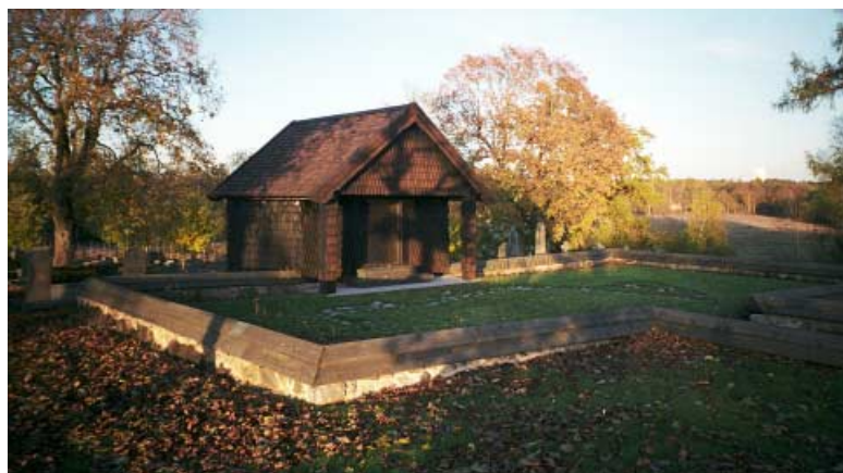
Minnesplatsen vid Sura gamla kyrka invigdes hösten 2003. Kyrkans gamla grundmurar har lagats och det tidigare kyrkorummet utgörs nu av en klippt gräsyta. Sommartid kan minnesplatsen användas för gudstjänster. Foto: Jakob Lindblad, 2003.
