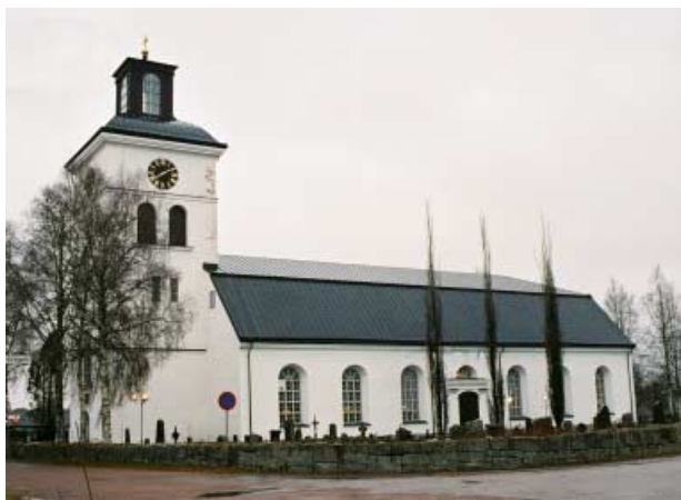
Järna kyrka brann 1978. Kyrkan återuppbyggdes och exteriören återställdes så långt det var möjligt. Foto: Anette Karls Fors, 2003.
