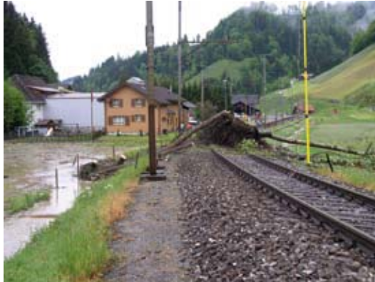
Abbildung 6: Baum auf Fahrbahn, Wiggen (Bild: SBB)
