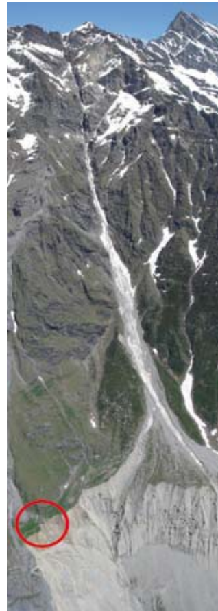
Abbildung 5 (links): In Bewegung geratener Hang am Mettenberg bei Grindelwald. Dem Rutsch fiel auch die Stiereggghütte (s. roter Kreis) zum Opfer.
