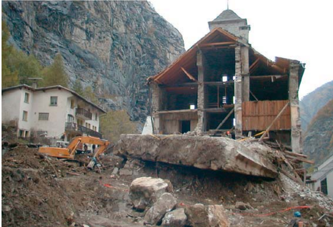
Abbildung 2: Murgang im Herbst 2000 in Gondo, VS, nach heftigen Niederschlägen. (Quelle: Vereinigung Kantonaler Feuerversicherungen, Kommission für Elementarschadenverhütung. VKF, Bern)
