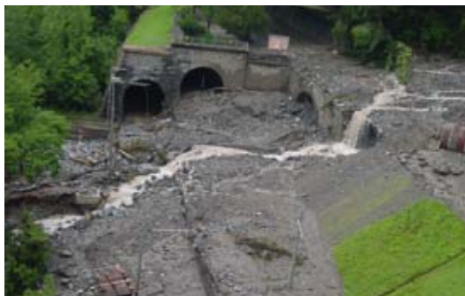
Abbildung 5: Hochwasser August 2005, Dornibach/SZ (Quelle: SBB)
