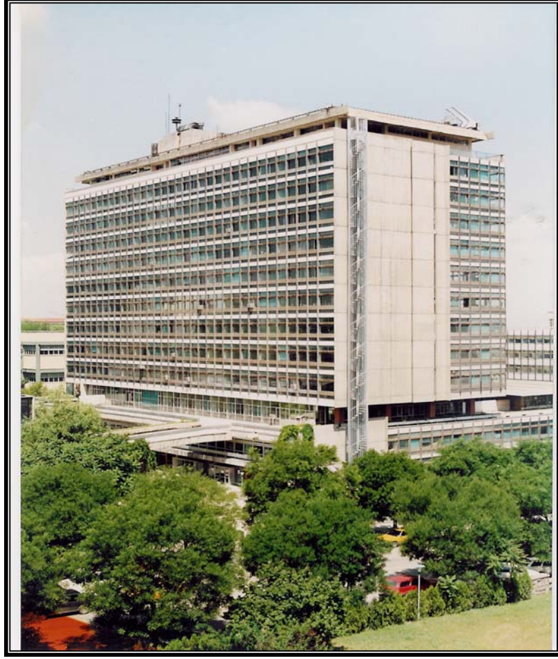
DSİ Genel Müdürlüğü Binası
