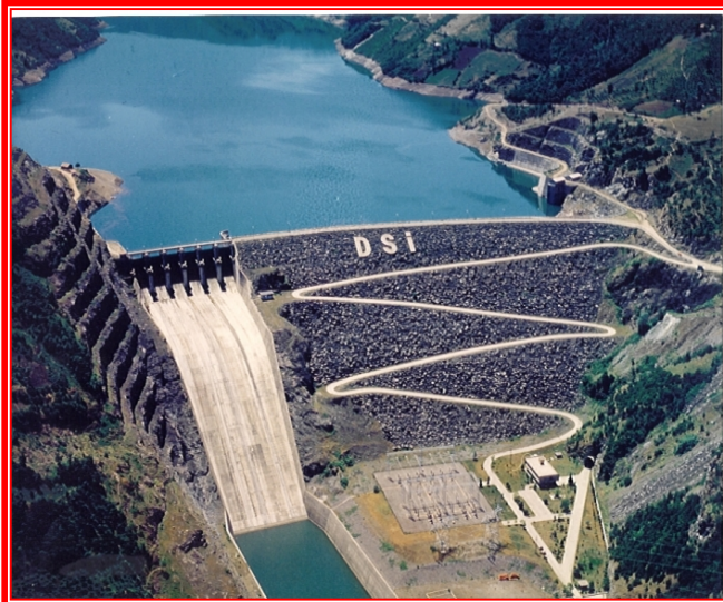
Hasan Uğurlu Barajı ve HES Samsun'da 1981'de işletmeye alınmıştır. (500 MW-1217 GWh/yıl)
