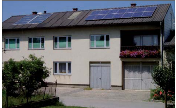
Solkraftwerk am Dach des energieautarken Bauernhofes
