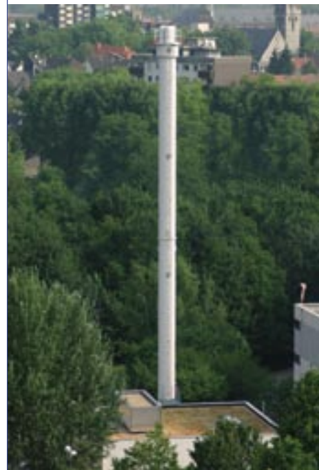
Energiezentrale am Marienhospital
