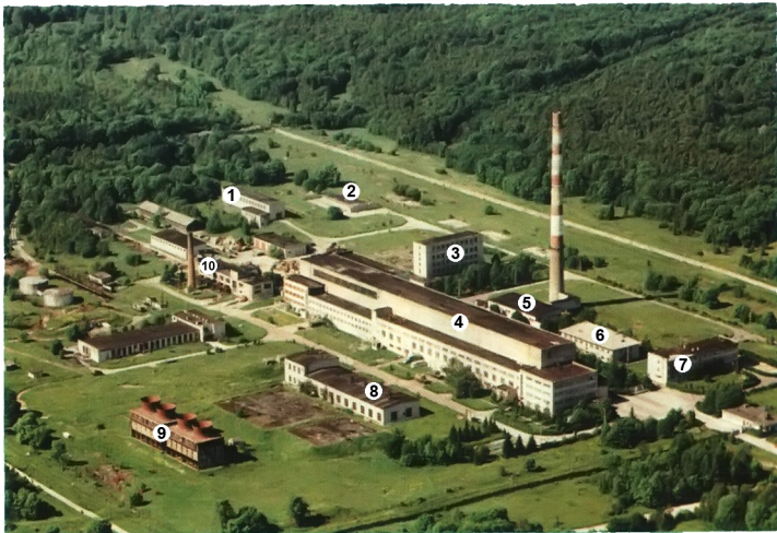
Paldiski tuumaobjekt: 1 - vedeljäätmete hoidla; 2 - tahkete jäätmete hoidla; 3 - vedeljäätmete töötlemiskompleks; 4 - peahoone kus asusid alveelaevamaketid; 5 - ventilatsiooni hoone; 6 - eripesula; 7- laboratiumihoone; 8 - jahutusvee pumbajaam 9 - gradiirid (jahutid) ; 10 - katlamaja.
