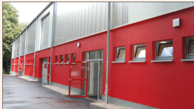
In sieben Monaten reiner Bauzeit entstand der ca. 600 Quadratmeter große Erweiterungsbau. Er bietet unter anderem Platz für vier Mannschaftskabinen und eine Garage für die Eismaschine.
