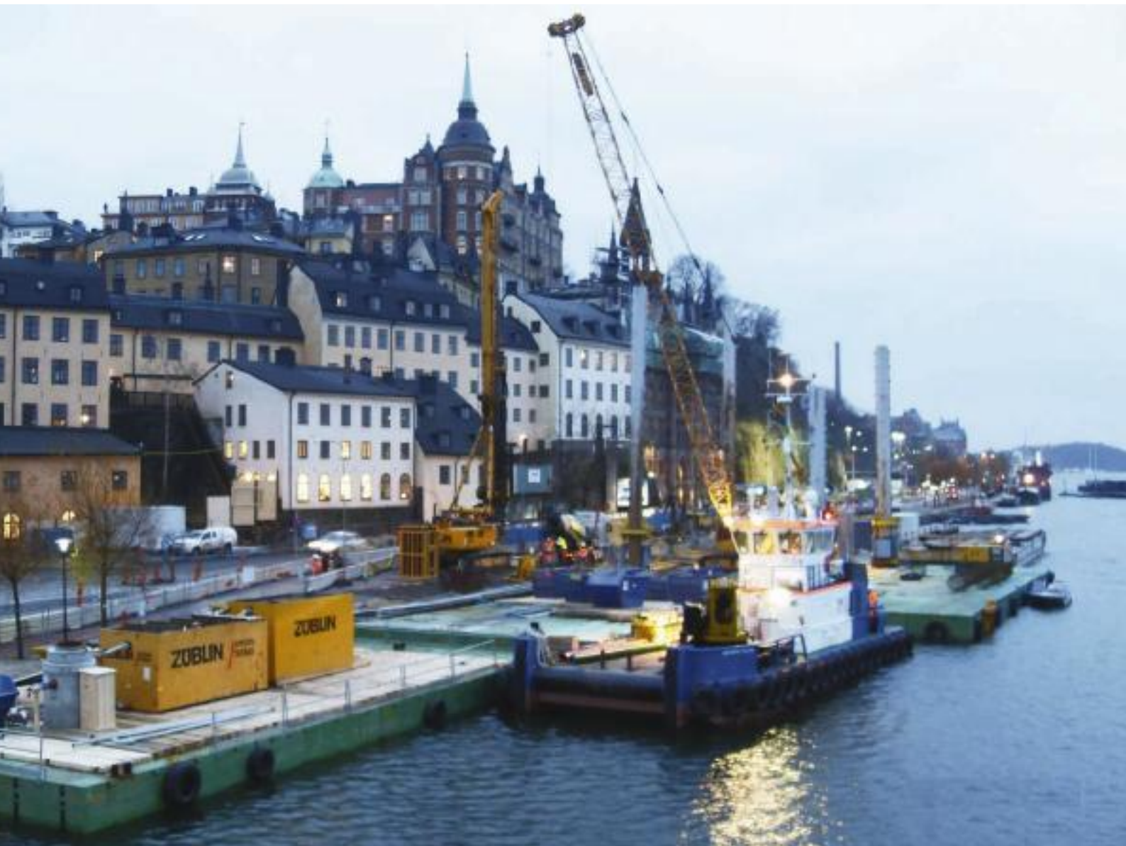
Vid Söder Mälärstrand och Riddarholmen byggs arbetsschakt där bergtunnlarna ska ansluta till sänktunneln som ska gå längs sjöbotten. Här sker en etablering vid Söder Mälärstrand. Foto: Züblin
