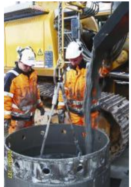
Borring för sekantpålvägg vid arbetsschakt Söder Mälarstrand. Borrmaskin B640 rotationsmaskin med vridmoment av 400 00 Nm. Borrhålsdiameter är 1,2 m. Foto: Züblin
