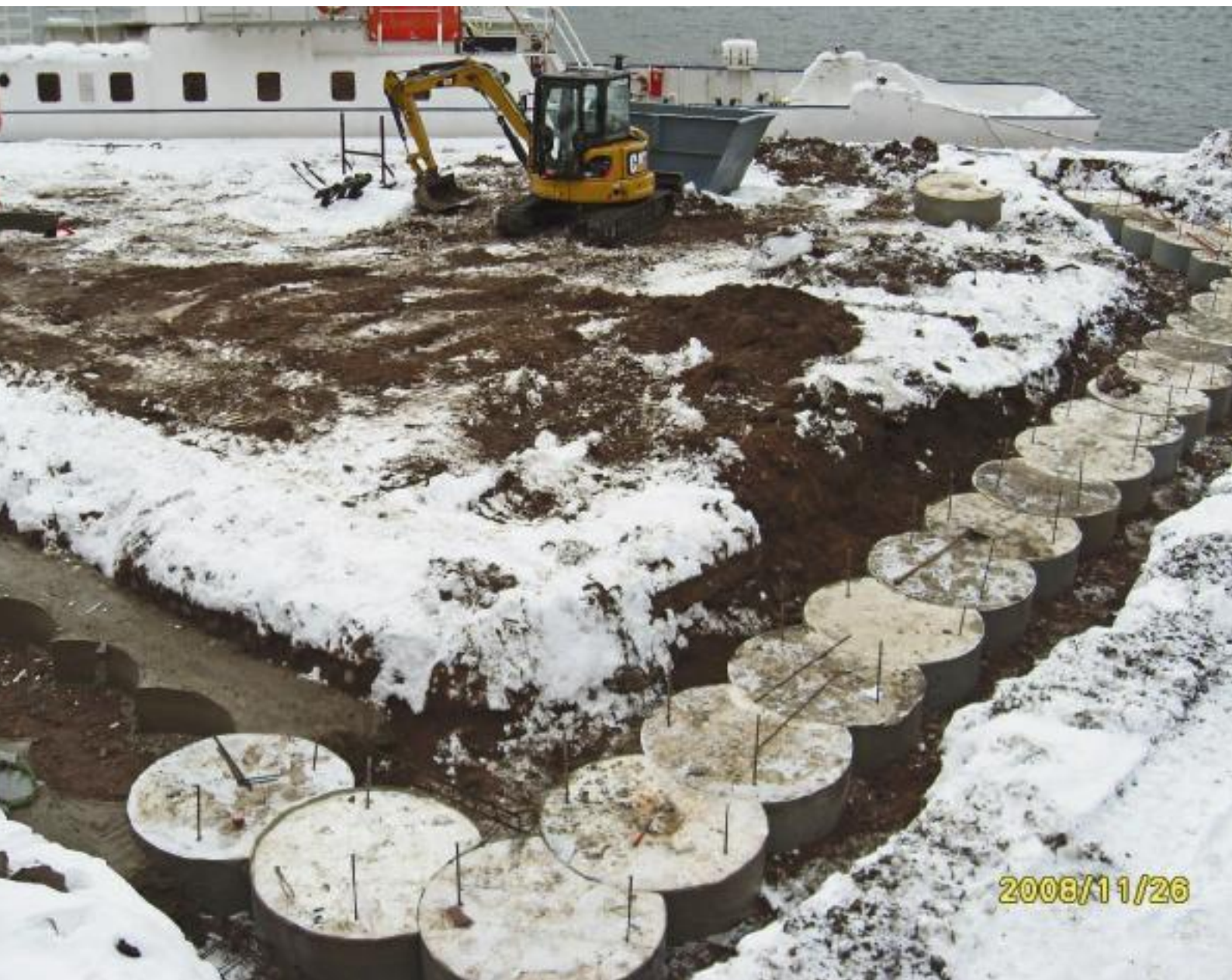
Början av en sekantpålevägg med borrhålsdiameter 1,5 meter som ligger vid arbetsschaktet på Riddarholmen. Foto: Züblin
