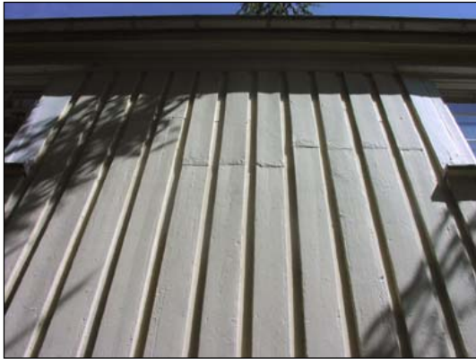
Detalj av fasadpanel.
