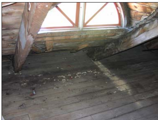
Röt- och mögelskador i golvplank på en av vindarna efter vattenläcka vid fönstret.
