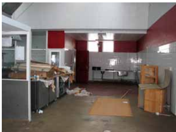
Fig 40. Det kaklade köket med ljusinsläpp från taklanternin.
