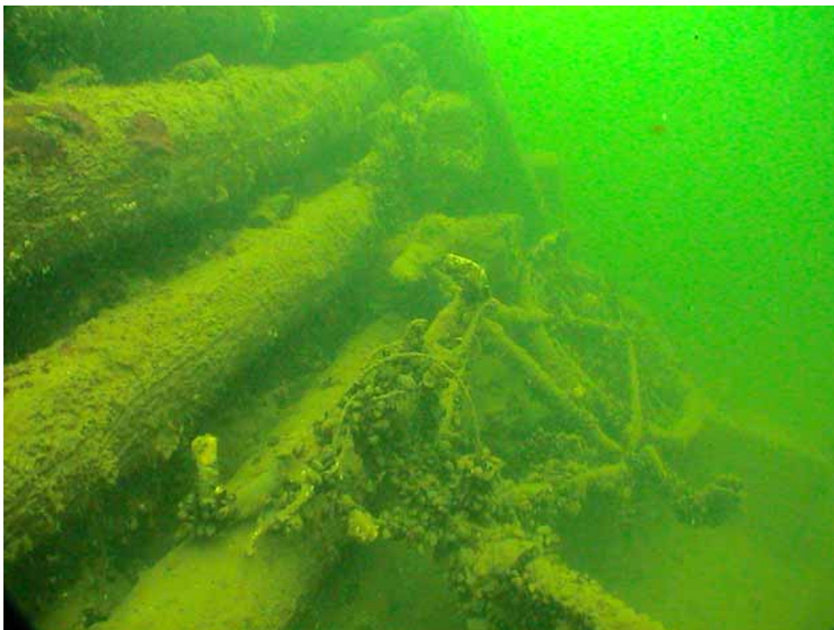
Fig 27. Timrad stenkista som utgör fundament till dagens bryggkonstruktion. Ursprungligen timrades kistorna som fundament till det vid förra sekelskiftet anlagda kallbadhuset på platsen. (L. Einarsson, 2010).
