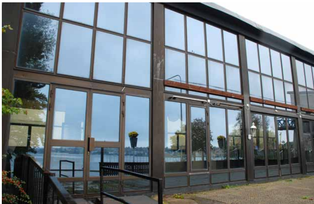
Fig 37. Detalj av den glasade fasaden, vilken byttes ut 1970. De mörktonade glasen och de bruna aluminiumprofilerna gav byggnaden ett helt annat fasaduttryck.
