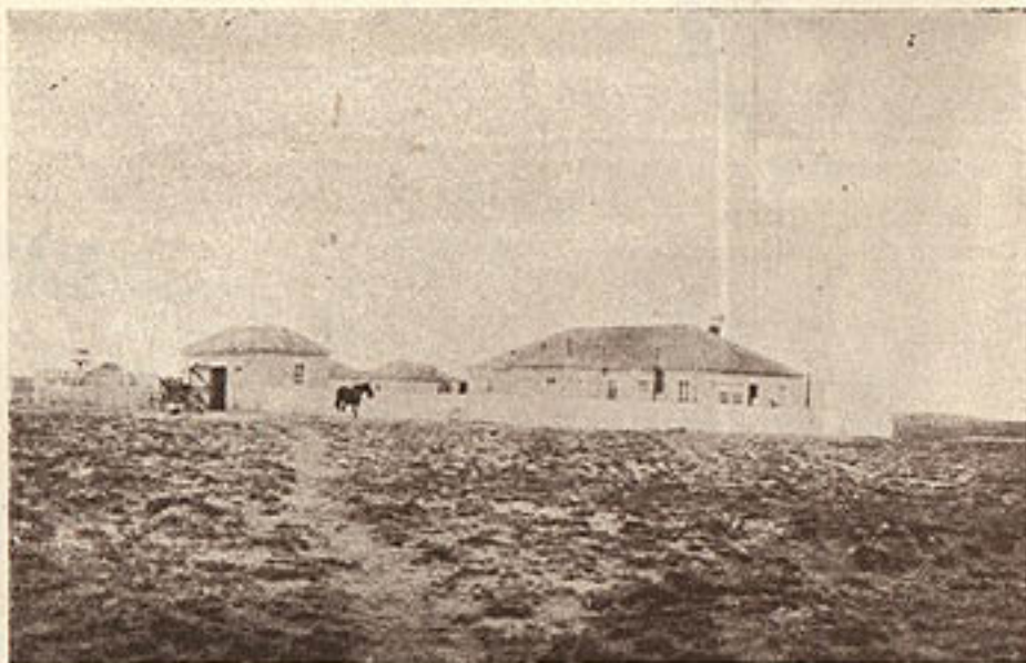
Fuentes del Coyle - Vista general de la Casa Administración
