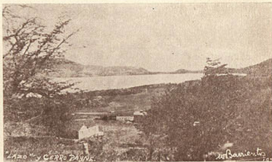
Cerro Guido.—Vista general de la Sección "Lazo"
