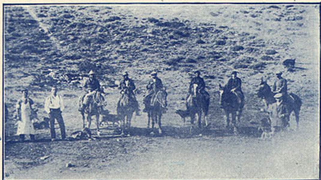
Campañistas preparados para dar principio a sus trabajos
