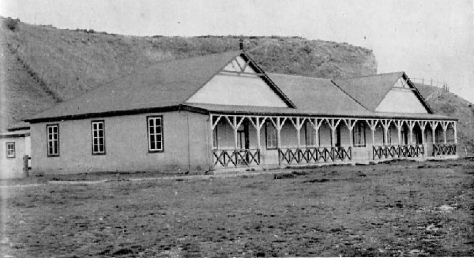
Exterior de cocina para obreros.
