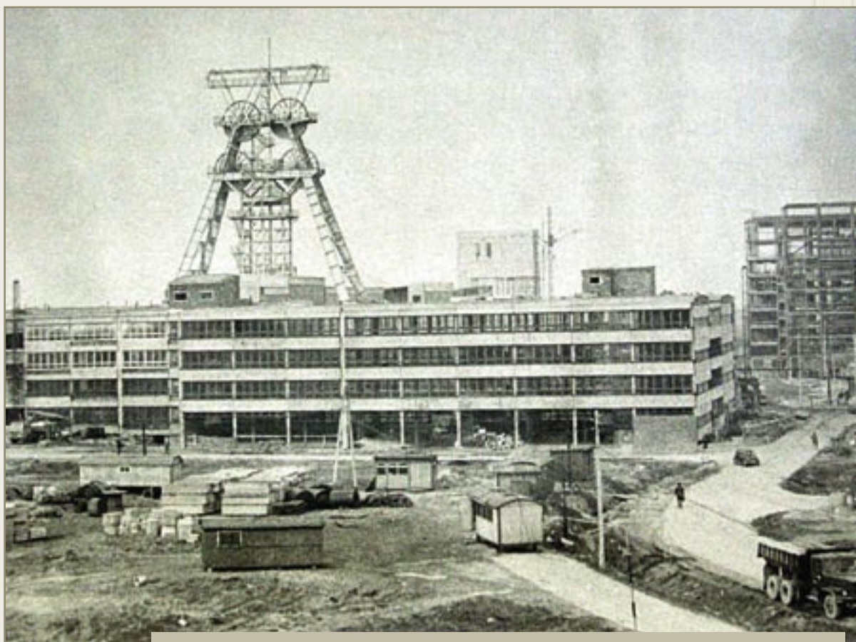
Zaawansowane roboty przy obiektach zakładu wydobywczego
