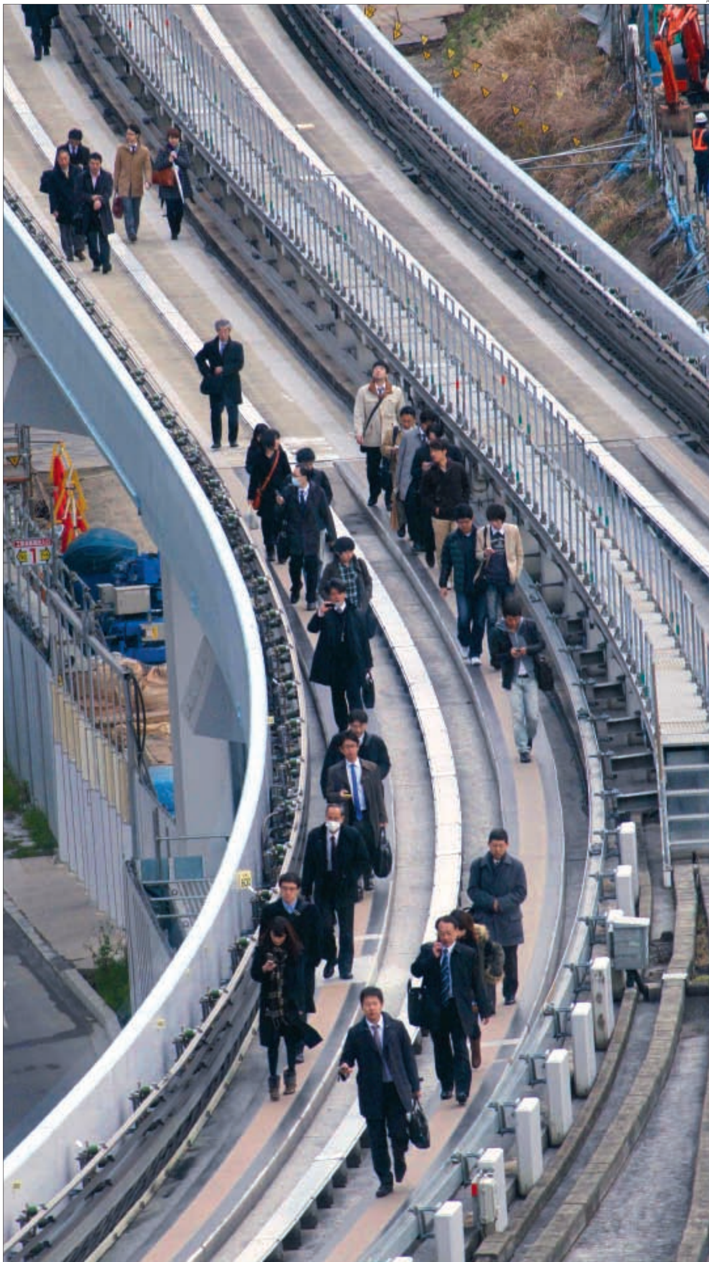
INFRAESTRUCTURA. Aunque el terremoto fue el mayor en los últimos 140 años, las carreteras cerca de Tokio resistieron el temblor.
