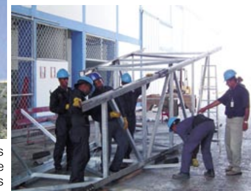
Construcción de una torre de 12 metros de altura.
