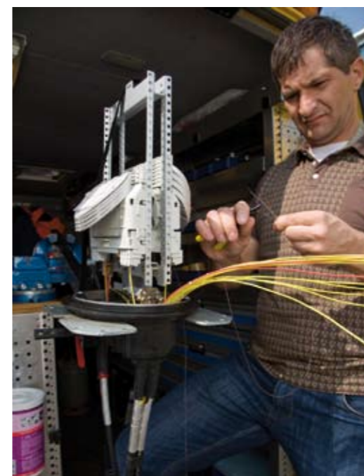
Agent P&T travaillant sur une fibre optique
