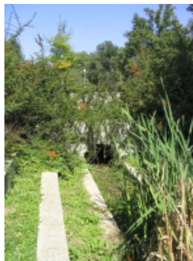
Slika 18: Betonski kanal ob Biološkem središču
