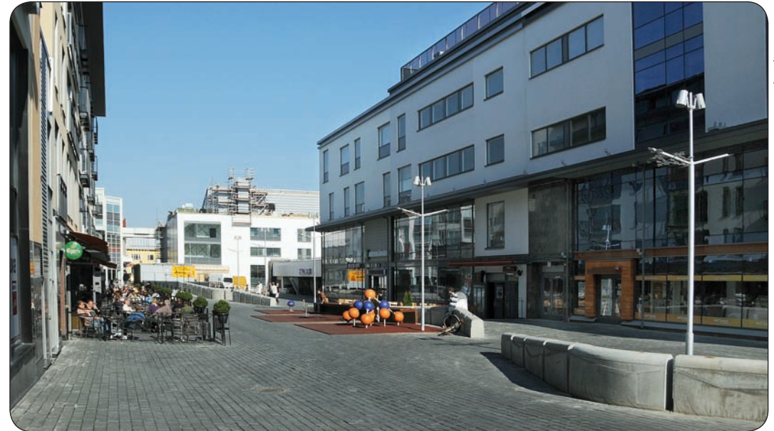
Kauppalaispihan saneeraus aloitettiin vuonna 2007. Alueesta toivotaan toimivaa kaupunkiaukiota. Syksyllä 2009 alkoi olla jo valmista.
