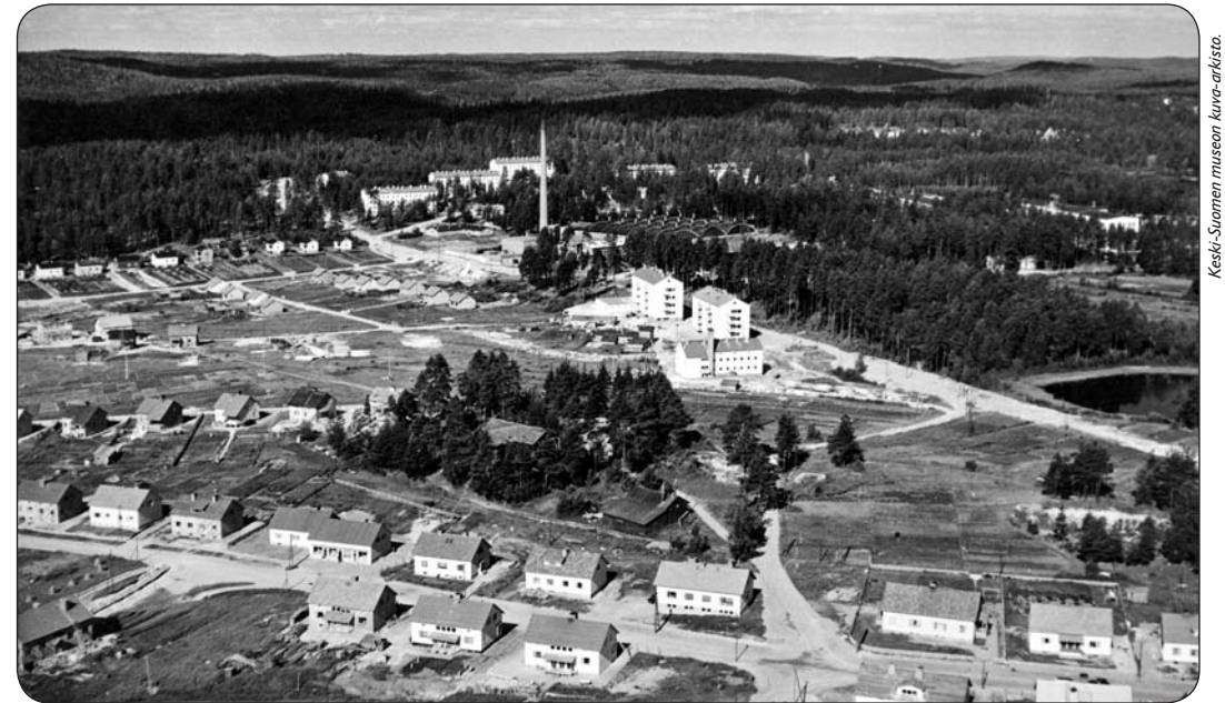
Mattilanpellon pientaloalue rakenteilla 1950-luvun alussa. Etualalla Mattilankatu ja taustalla Keskussairaalan tie, jonka varrelle on valmistunut jo muutama kerrostalo. Valmetin paperikonetehtaan piipun takana tehtaan kerrostaloja.
