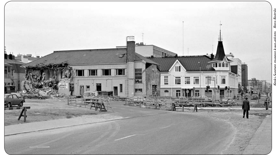
Keskustan saneerausta Asemakatu 5 kohdalla lokakuussa 1979. Vapaudenkadun ilme alkoi muuttua syksyllä, kun vanhojen puutalojen ja kuvassa näkyvän kaksikerroksisen liikerakennuksen tilalle alettiin rakentaa uutta kauppakeskusta. Kuvassa kadun ali tehdään maanalaiseen autopaikoitukseen johtavaa ajoluiskaa.
