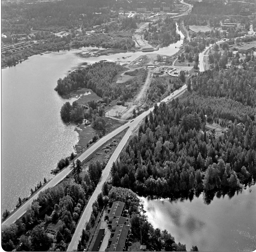
Rantaväylän rakennustyömaa Palokkajärven eteläpäässä kesällä 1985. Etualalla Tuomiojärven ja Palokkajärven yhdistävä Löylyjoki.
