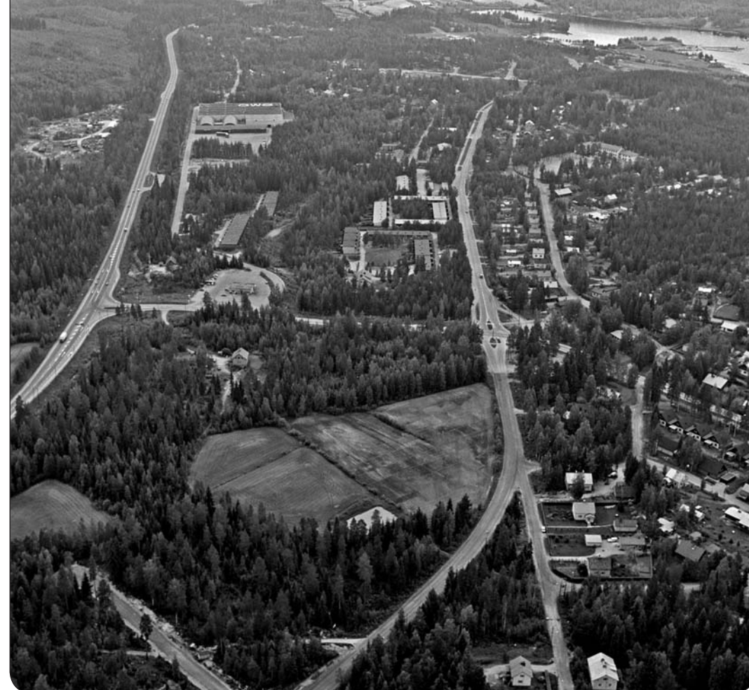
Vuonna 1985 otetussa kuvassa oikealla Keljonkankaantie ja vasemmalla Helsinki-Oulu valtatie (E4), nykyinen Ysitie.
