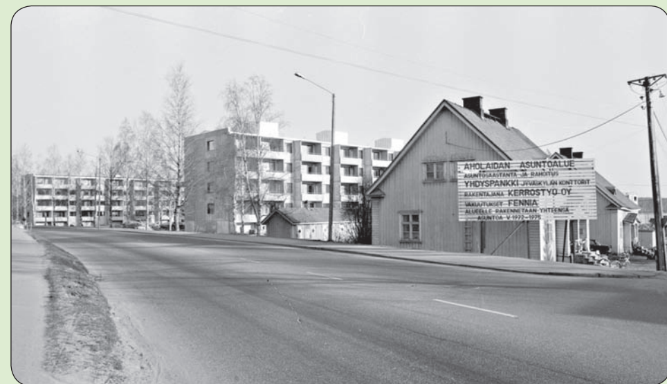
Vaajakoskentieä Aholaidan kohdalla vuonna 1974. Vanhat Schaumanin vaneritehtaan työläisten asunnot ovat saaneet väistyä uusien kerrostalojen tieltä.
