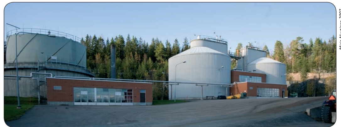
Jyväskylä ja Jyväskylän maalaiskunta perustivat Nenäinniemen jätevesipuhdistamon vuonna 1967 tekemällään päätöksellä. Vuonna 1971 perustivat edellä mainitut kunnat ja silloinen Keski-Suomen keskussairaalan kuntainliitto Jyväskylän Seudun Jätevedenpuhdistamo Oy:n. Vuodesta 1997 lähtien yhtiön nimi on ollut Jyväskylän Seudun Puhdistamo Oy, ja sen osakaskuntia ovat edellä mainittujen lisäksi Laukaa ja Muurame.
