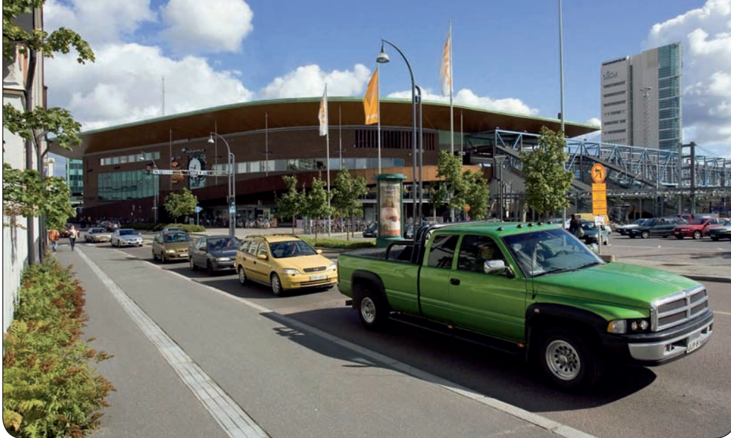
Jyväskylän Matkakeskus on arkkitehtien Trevor Harris, Henu Kjisikin suunnittelema ja vuonna 2002 käyttöön otettu rakennus. Kokonaisuuteen kuului myös Petri Rouhiaisen piirtämä toimistorakennus.
