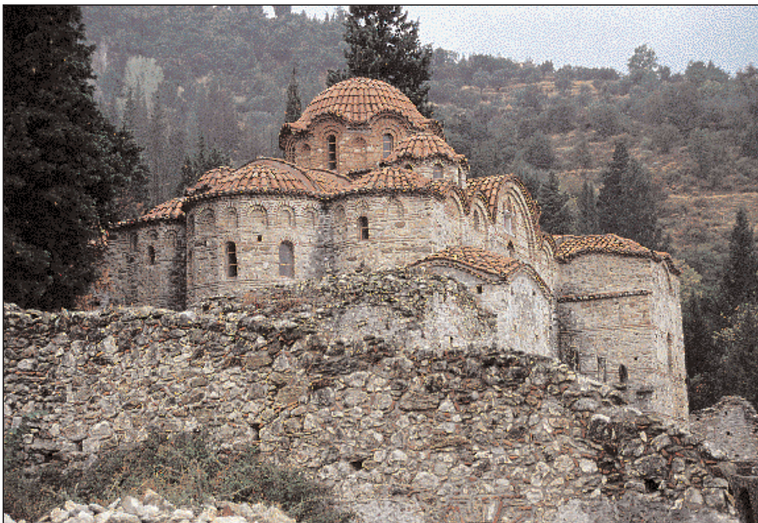
Το Αφεντικό, εξωτερική άποψη. Το κτίριο έχει τη μορφή διώροφου πεντάτρολλου σταυροειδούς ναού, σχήμα αρκετά νεωτεριστικό για τον Μυστρά, αν σκεφθούμε ότι από την παραδοσιακή οικοδόμηση των Αγίων Θεοδώρων μεσολάβησαν μόνον είκοσι χρόνια.
