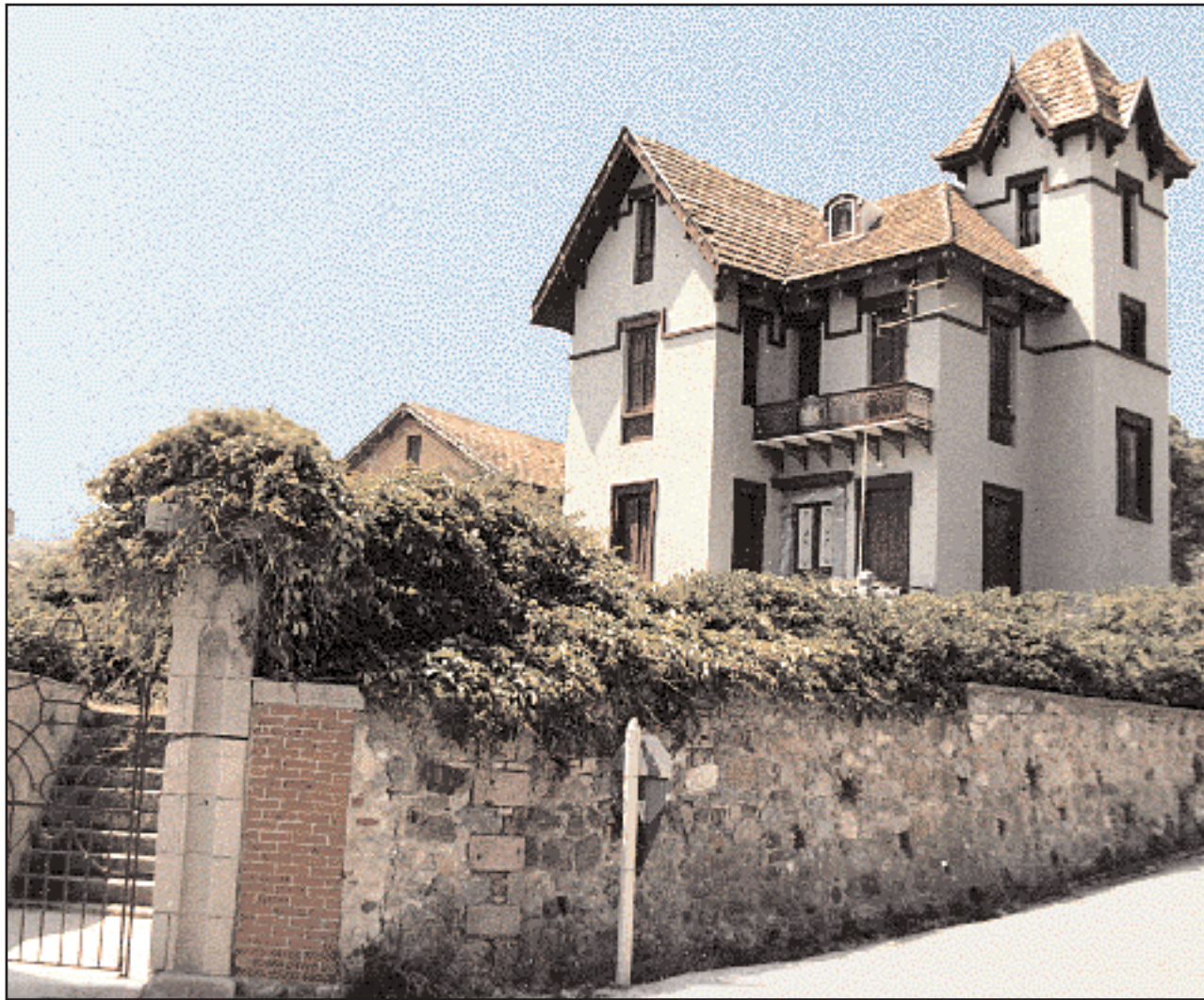
Οικία Ι. Γιανέλλη. Κτίστηκε το 1912 και αποτελεί χαρακτηριστικό δείγμα στηλ Picturesque . (Φωτ.: Μίκα Λαμπροπούλου-Παπαευστρατίου).
