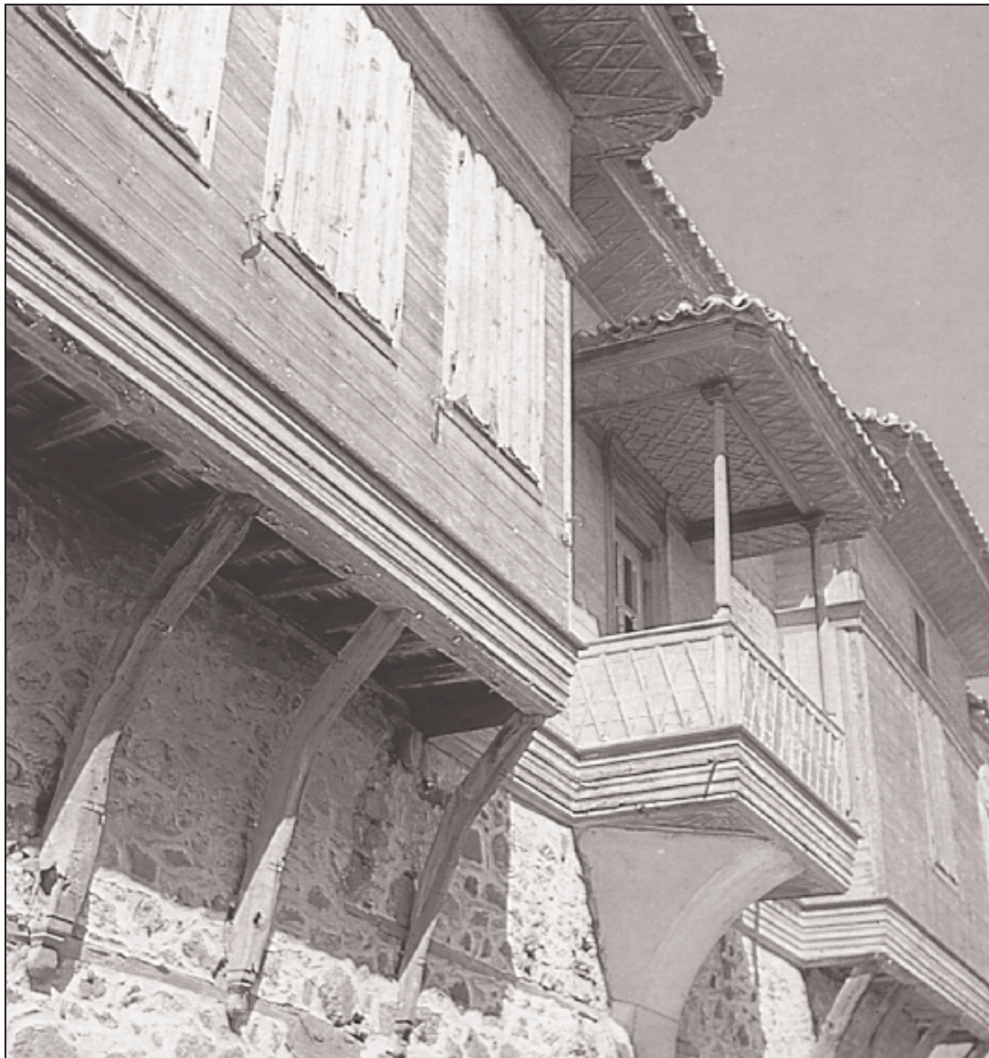
Το αρχοντικό της Βαρελτζίδαινας στην Πέτρα. Πρόσωση από το δρόμο. Στο μεγάλο λεπτοδουλεμένο γείσο της στέγης και στο πλαστικό σχήμα των φουρουσιών και του εξώστη ο Κοντής διακρίνει την επίδραση του μπαρόκ.
