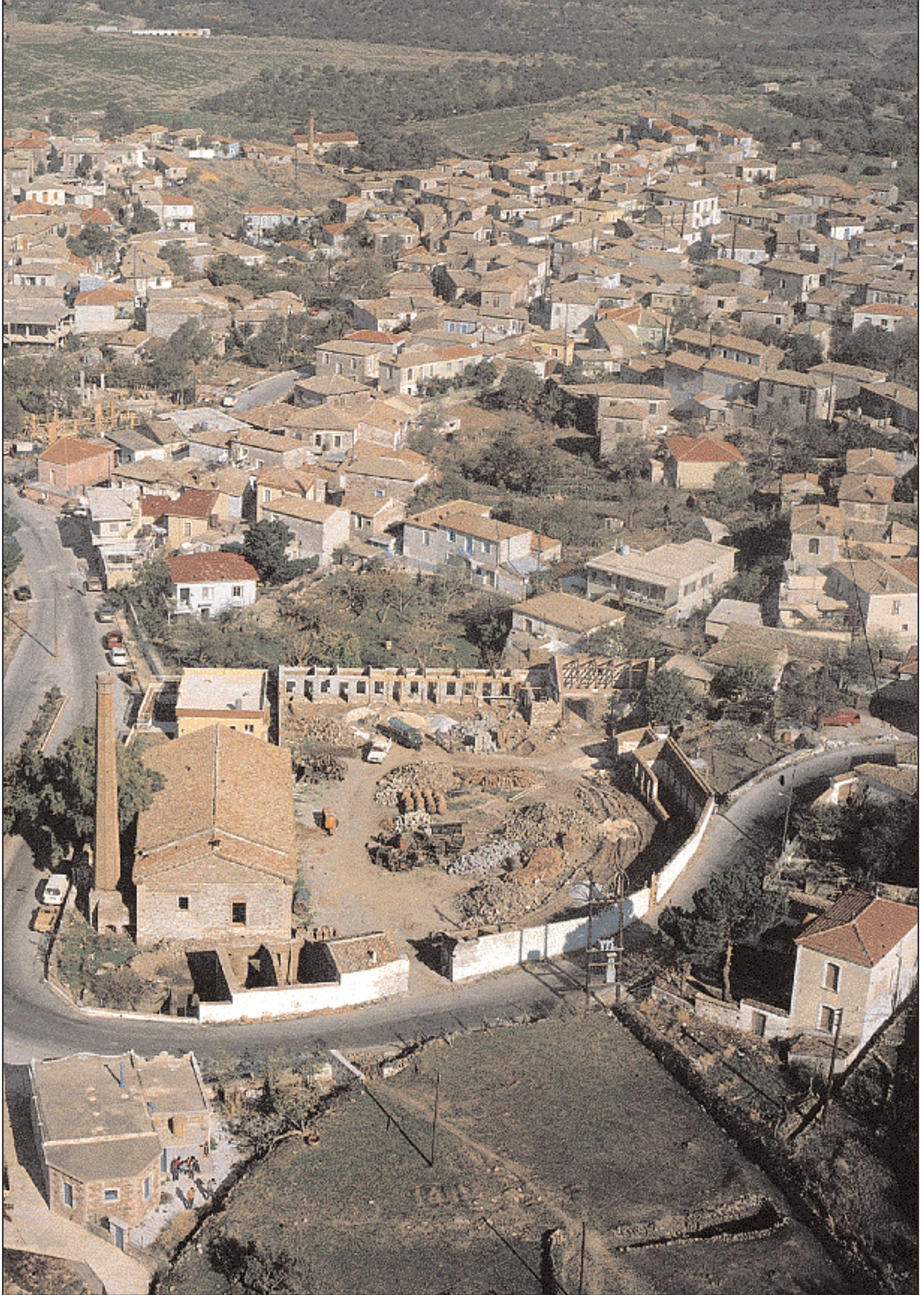
Το Κοινοτικό Ελαιοτριβείο Μανταμάδου. Αρχισε να κτίζεται το 1905 και από μορφολογική άποψη κατατάσσεται στα χαρακτηριστικά δημιουργήματα βιομηχανικής αισθητικής του τέλους του 19ου αιώνα. Όπως φαίνεται και στη φωτογραφία, στους οικισμούς της Λέσβου, τα διάσπαρτα νεοκλασικά κτίσματα, όπως και τα λαϊκά με τις δικλινείς ή τετρακλινείς στέγες συνυπάρχουν αρμονικά με τις στέγες και τους νεοκλασικούς όγκους των εργοστασίων.
