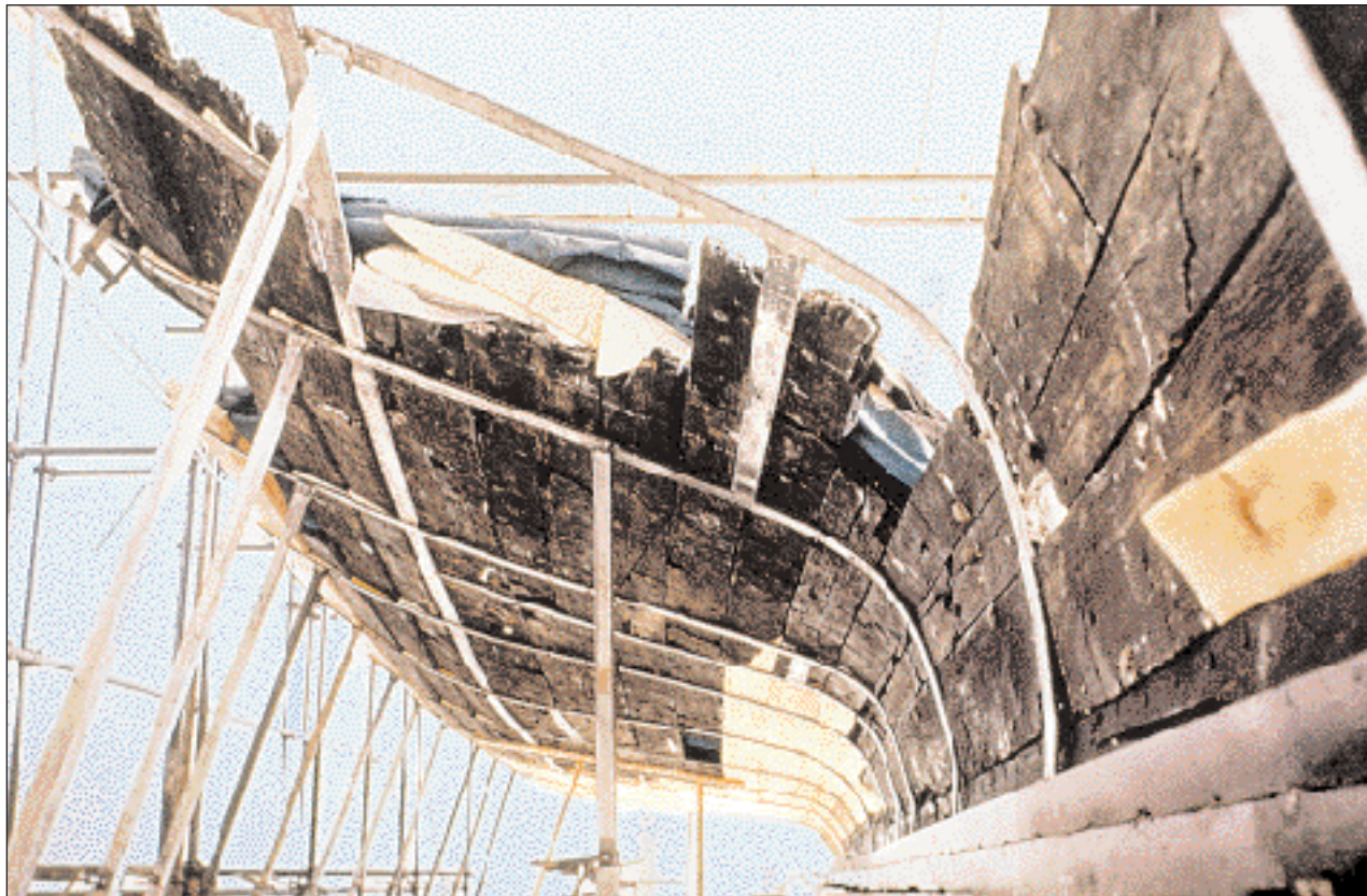
◀ Η ανασυναρμολόγηση της συντηρημένης ξυλείας του καρρηδονιακού πλοίου.
