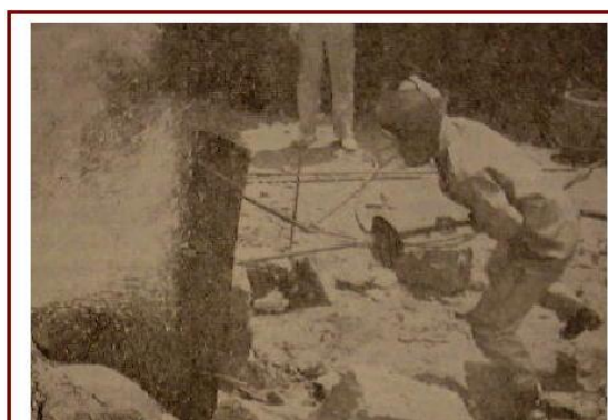
酸素槍による粗切断は、現在でも大きな非金属塊の分離などで使われている。写真は1960年での厚さ250mmのコンクリート柱の解体作業中のものである。
