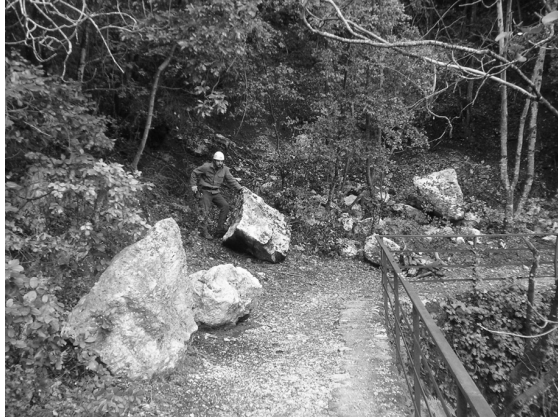
Fig. 7 Rockfalls on the Giro dei Condotti footpath
