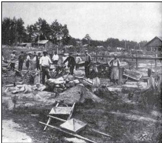
Работы на месте будущего главного корпуса
