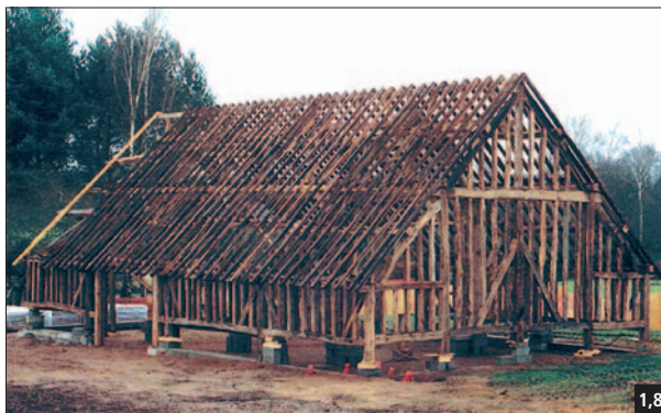
Fig. 1,8 et 1,9 Ce mode de construction permet de rénover des bâtiments anciens.
