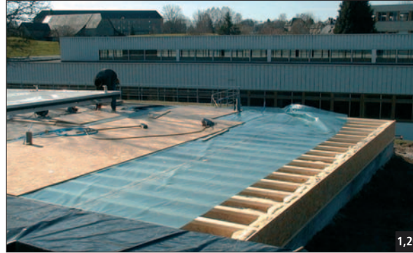
Fig. 1,18 La majorité des maisons à ossature bois ont une ossature plate-forme.
