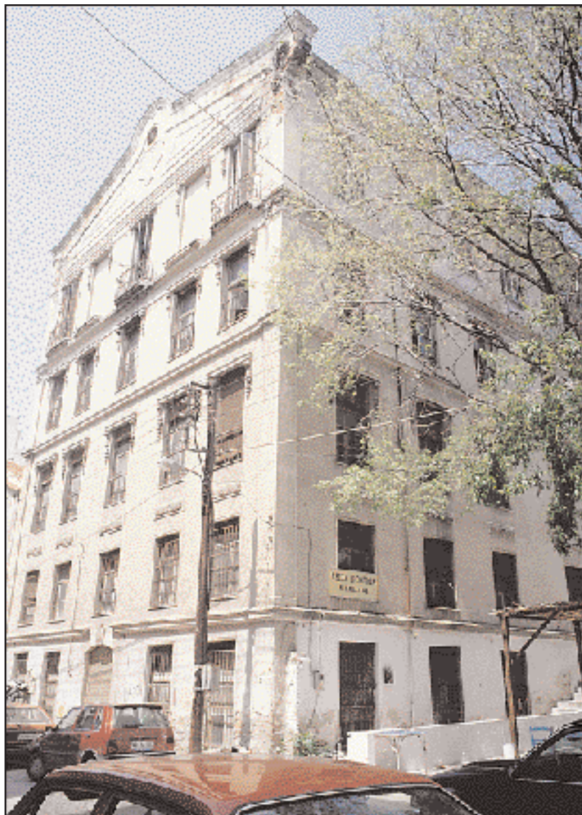
Καπναποθήκη, κτίριο εκλεκτικιστικού ρυθμού στην οδό Φιλίππου, στην Καβάλα (Φωτ.: Σ. Αγγελούδη - Ζαρκάδα).
