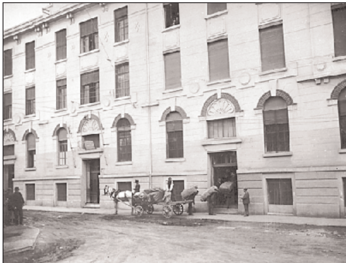
Η καπναποθήκη της εταιρείας Salonica , στην οδό Πτολεμαίων. Είχε κτισθεί το 1924 σε σχέδια του μηχανικού Ε. Μοδιάνο . Εχει κατεδαφιστεί (φωτ.: αρχείο Εταιρείας Salonica ).
