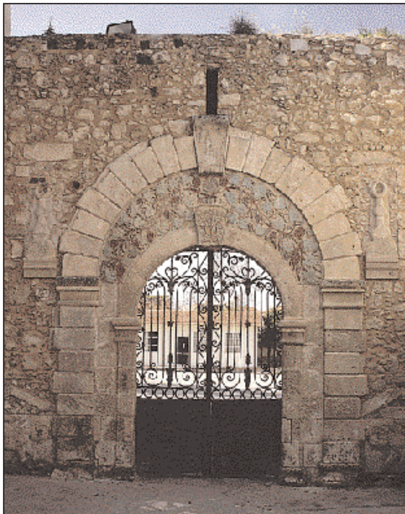
Η είσοδος του Τούρκικου Δημοτικού Σχολείου, το οποίο λειτουργεί ακόμη και σήμερα. Ονομάζεται τούρκικο, γιατί κτίστηκε από τους Τούρκους, αλλά ήταν μίμηση του αναγεννησιακού κτιρίου του Αγίου Φραγκίσκου. Το ύψος και ο διάκοσμος στο υπέρθυρο είναι επηρεασμένα από τους Βενετούς (φωτ.: Δημ. Αντωνίτσας).
