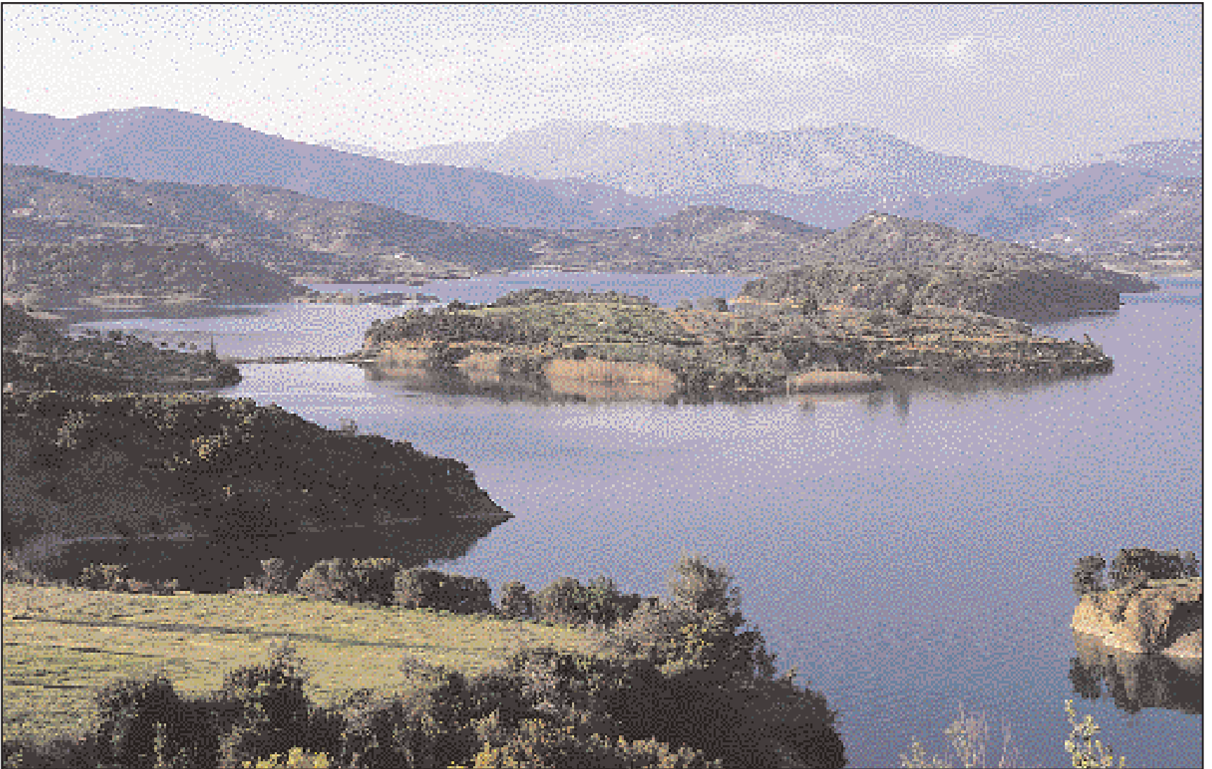
Η τεχνητή λίμνη Καστρακίου που δημιουργήθηκε με τα νερά του ποταμού Αχελώου. Δέκα δισεκατομμύρια κυβικά μέτρα καθαρού νερού αποταμιεύονται σήμερα μέσω των τεχνητών λιμνών (φωτ.: Γ. Τσουνής).
