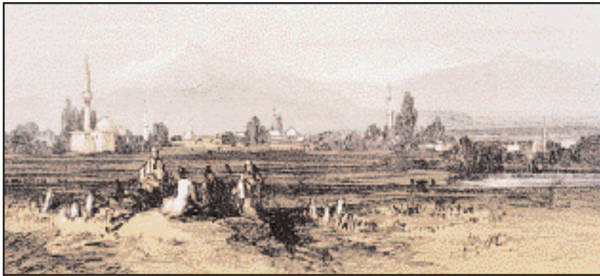
Τα Γιαννιτσά και η ομώνυμη λίμνη που υπήρξε κέντρο των Μακεδονομάχων, γνωστή και από το βιβλίο της Πηνελόπης Δέλτα «Τα μυστικά του Βάλτου». Η αποξήρανση της λίμνης έγινε δυνατή με την κατασκευή διώρυγας μήκους 32 χλμ. το 1937 (φωτ.: υδατογραφία του Edward Lear, 1849).
