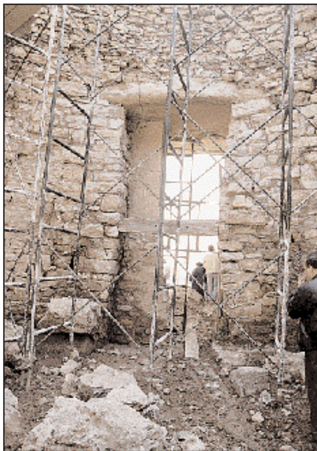
Ανασκαφικές εργασίες στο εσωτερικό του τάφου του Αιγίσθου στις Μυκήνες. Η μελέτη και η επίβλεψη του έργου γίνεται από την αρχιτέκτονα κ. Παλυβού με την εποπτεία της Δ' ΕΠΚΑ Ναυπλίου.
